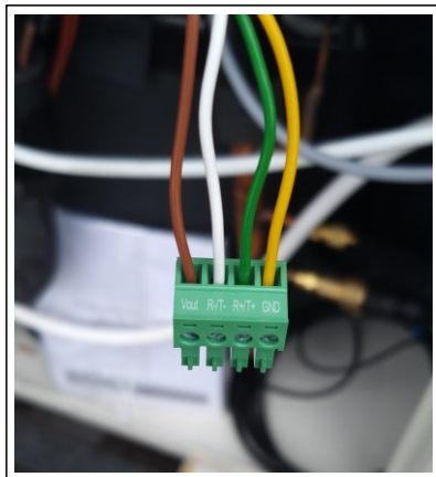
Podłączenie przewodów z panelu sterującego do wtyczki w pompie ciepła
